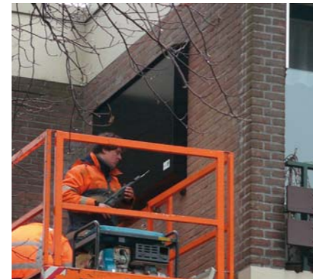
In te metselen permanente vleermuiskast. De buitenzijde wordt afgewerkt met metselwerk zodat alleen de invliegopening zichtbaar is.
